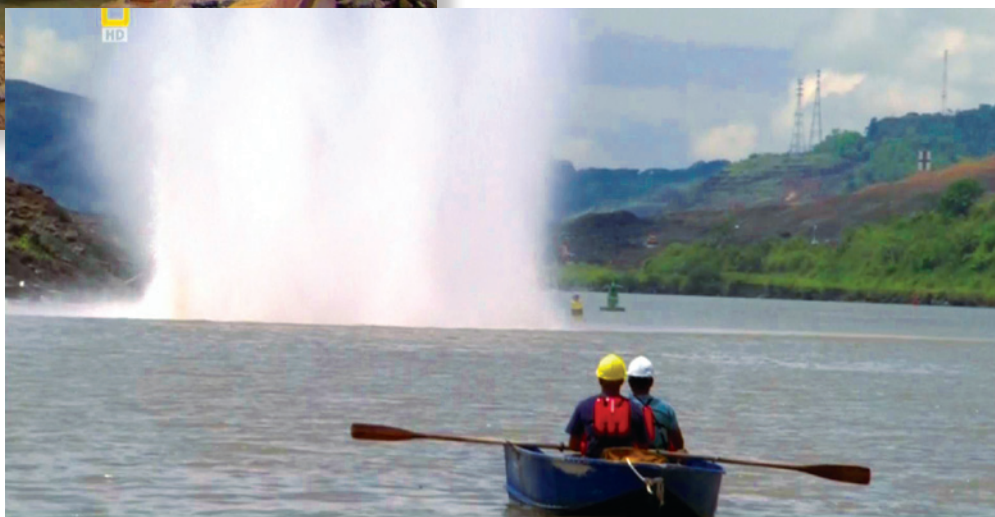
Кадры съемки работ по реконструкции канала
